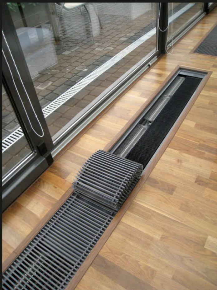
Boden Konvektoren, Neue Generation
